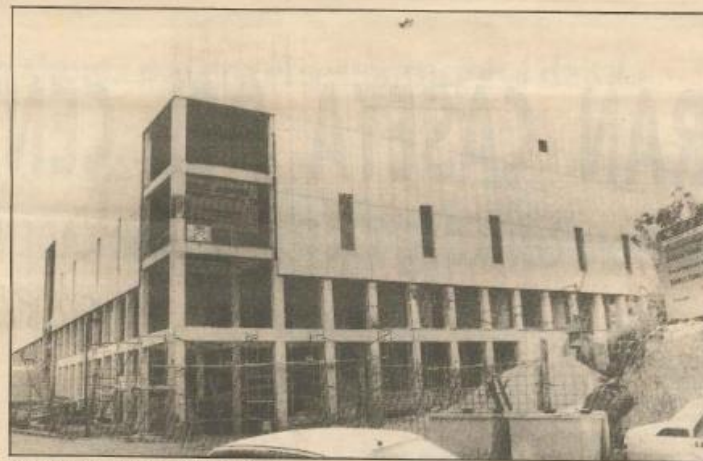
Estado de las obras de la nueva biblioteca.
